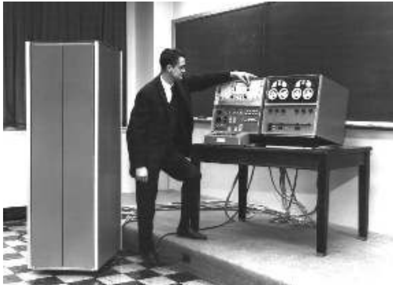
Εικόνα 10: Ο LINC (Laboratory INstrument Computer) θεωρείται ο πρώτος προσωπικός υπολογιστής, γιατί σε έναν σχετικά μικρό όγκο περιλαμβάνει μια συσκευή εξωτερικής αποθήκευσης και κυρίως μία οθόνη και ένα πληκτρολόγιο ως σύστημα εξόδου και εισόδου. Σε αντίθεση με τους μεγάλους κεντρικούς υπολογιστές εκείνης της εποχής, ήταν σχεδιασμένος από την αρχή σε συναρμολογούμενη μορφή, οπότε ήταν σχετικά προσιτός σε πολλά ερευνητικά εργαστήρια που είχαν τις δεξιότητες να τον κατασκευάσουν και να τον συντηρήσουν.
