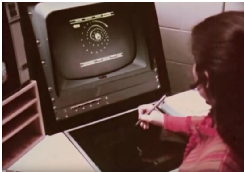
Εικόνα 8: Το σύστημα οπτικού προγραμματισμού Genesys απευθύνεται σε σχεδιαστές γραφικών κίνησης, οπότε βασίζεται στην οικεία για αυτούς πένα και σε λογισμικό σχεδίασης αντικειμένων. Παρουσιάζει καινοτόμες λειτουργίες διάδρασης, όπως είναι η χειρονομία για την σχεδίαση μια τροχιάς κίνησης, όπου εκτός από την ίδια την τροχιά καταγράφεται και ο ρυθμός.
