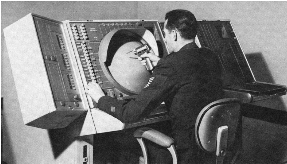
Εικόνα 7: Ένας από τους μεγαλύτερους σε μέγεθος και πολύ ισχυρός υπολογιστής της δεκαετίας του 1950 ήταν ο SAGE (Semi-Automatic Ground Environment), ο οποίος συγκέντρωνε τα δεδομένα πτήσεων από ένα δίκτυο ραντάρ και τα πρόβαλε στην οθόνη μαζί με απλά γραφικά χάρτη. Ο χρήστης μπορούσε να επιλέξει ένα σημείο στο ραντάρ με την βοήθεια μια αρχικής μορφής πένα, για να ταυτοποιήσει το αντίστοιχο αντικείμενο.
